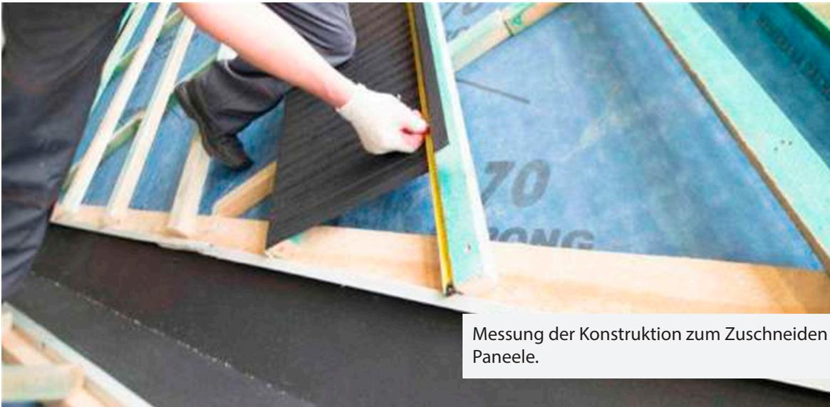
Messung der Konstruktion zum Zuschneiden der Paneele.
