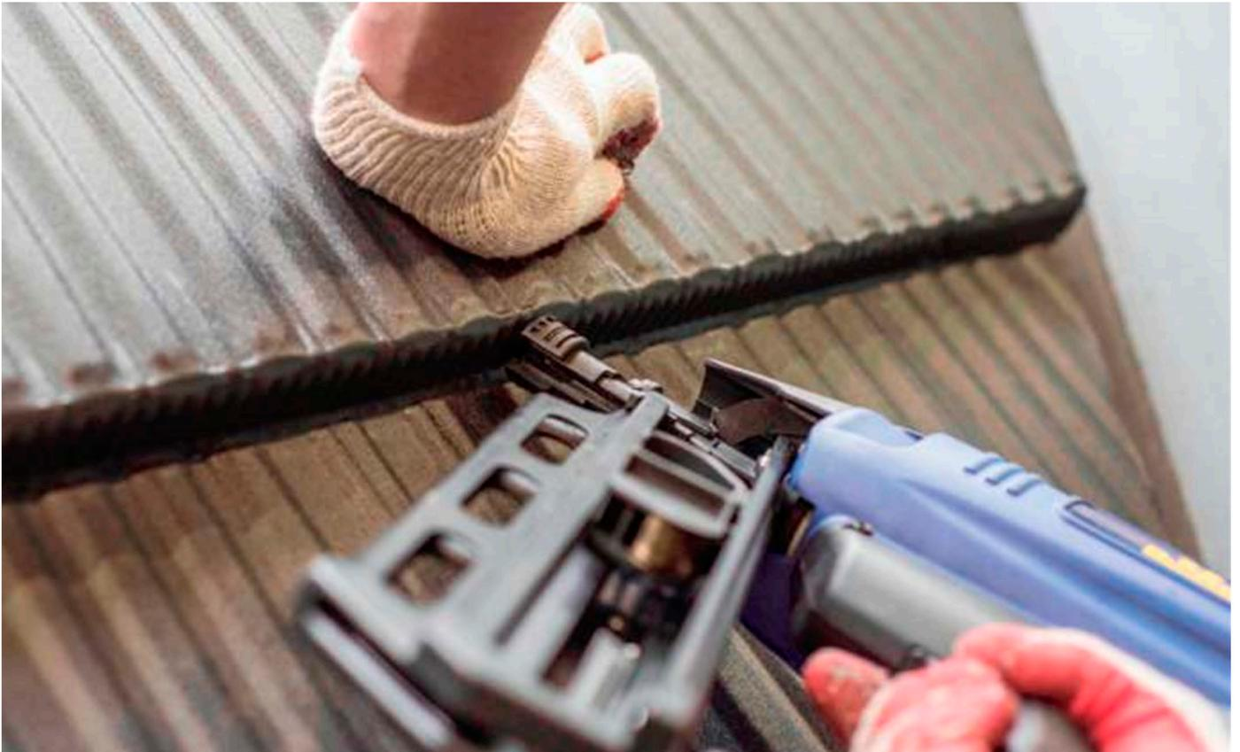
Es wird empfohlen, die Montage mit TORX-Schrauben vorzunehmen. Die Montage mit Nageln oder Schraubnagel mit einer Nagelpistole ist ebenfalls zulässig.
