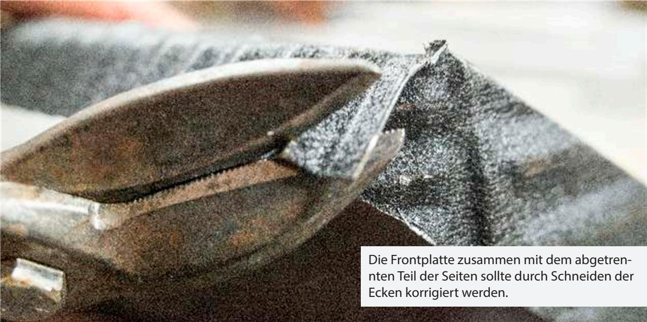
Die Frontplatte zusammen mit dem abgetrennten Teil der Seiten sollte durch Schneiden der Ecken korrigiert werden.
