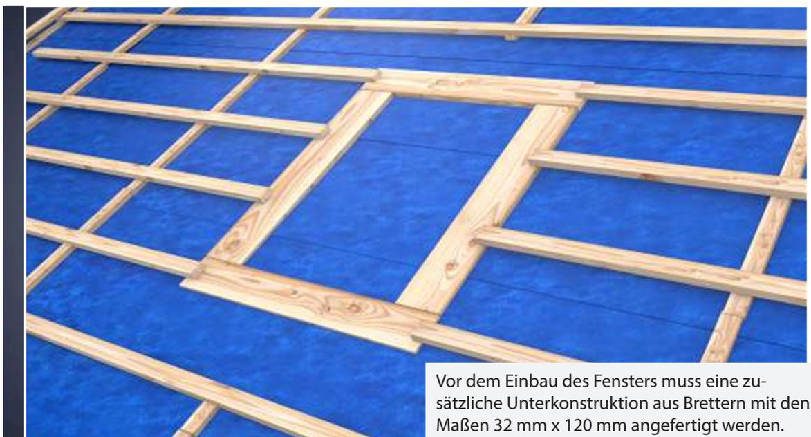
Vor dem Einbau des Fensters muss eine zusätzliche Unterkonstruktion aus Brettern mit den Maßen 32 mm x 120 mm angefertigt werden.
