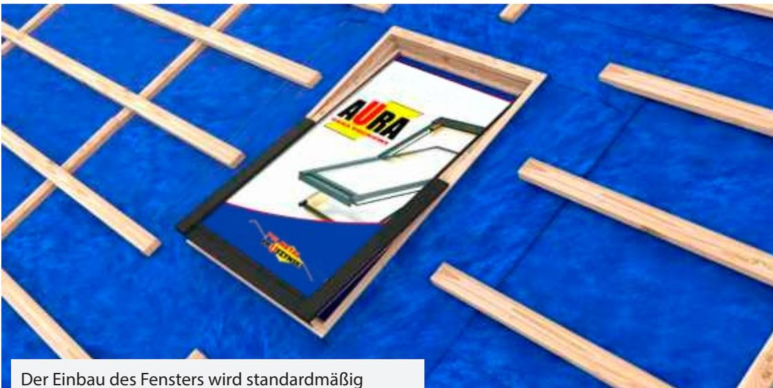
Der Einbau des Fensters wird standardmäßig mit einer Membran durchgeführt, wobei auf die Dichtigkeit der Verbindung zu achten ist.
